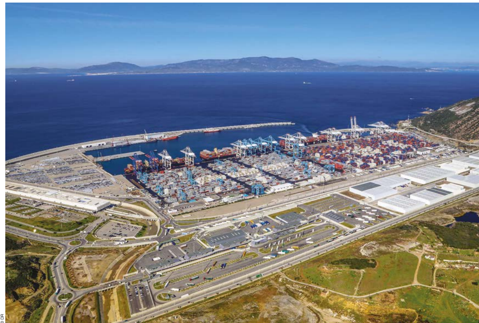
Le port de Tanger Med. / The Tanger Med port.
