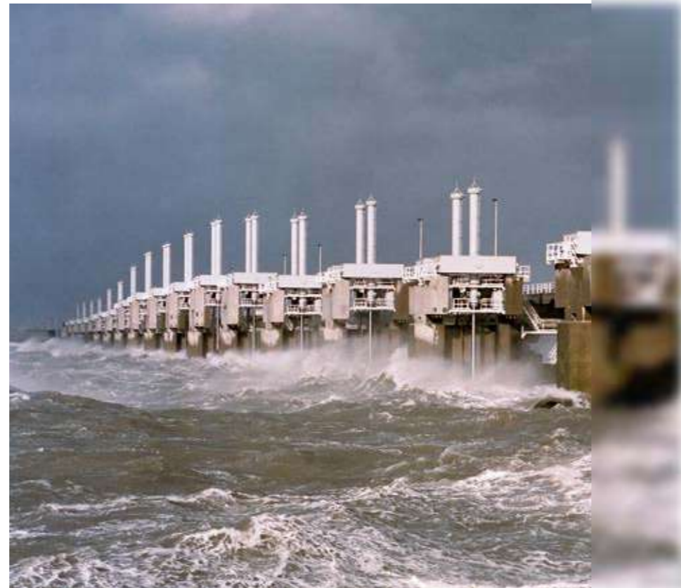
Le barrage de l'Escaut oriental, entre Schouwen-Duiveland et l'île de Beveland-Nord aux Pays-bas, 9 km de long, est le plus important ouvrage du plan Delta, lui-même le plus grand programme de défense au monde contre la montée des eaux.
