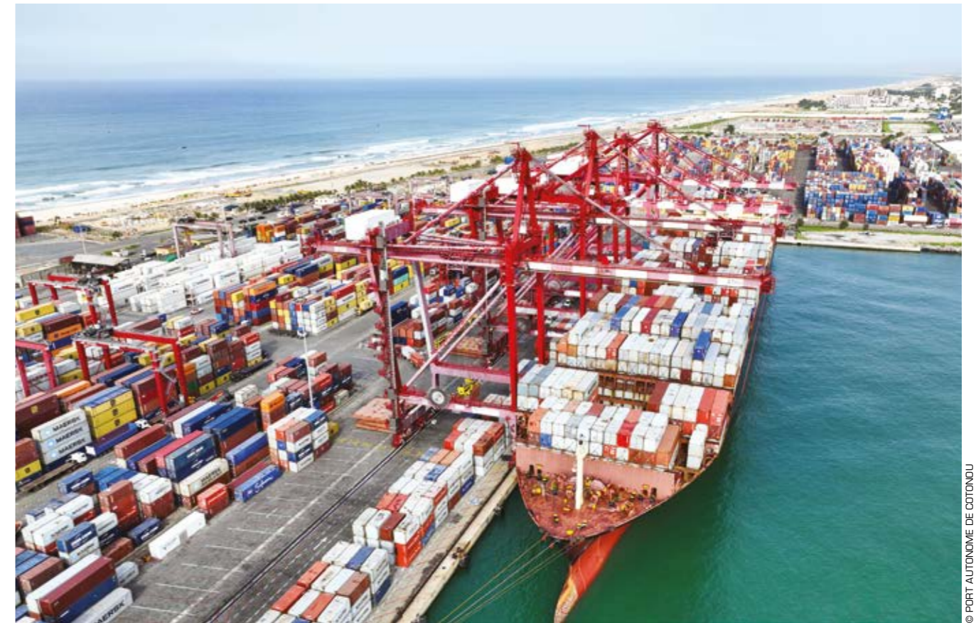
« Pour améliorer le potentiel logistique du pays, l'un des enjeux majeurs du secteur maritime au Bénin, des projets de modernisation du port de Cotonou sont en cours. » / "With a view to improving the country's logistics potential, one of the major challenges for Benin's maritime sector, projects to modernise the port of Cotonou are currently underway." José Didier Tonato
