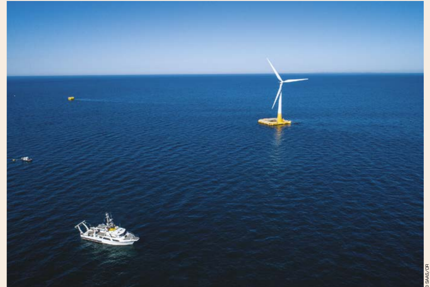
Les navires Minibex et Sterenn Red de SAAS sur le site d'essais SEM-REV opéré depuis 2023 par la Fondation OPEN-C. SEM-REV est depuis 2015 un site d'essais essentiel pour les énergies marines renouvelables (EMR) en France. Les expertises de SAAS y sont régulièrement sollicitées pour des opérations d'installation ou de maintenance de prototypes EMR, de leurs systèmes d'ancrage et de câbles sous-marins.
