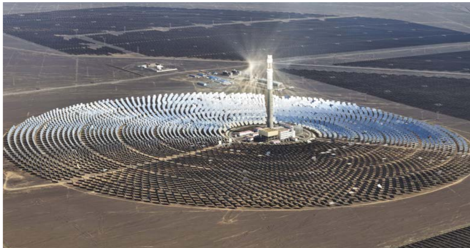
Centrale solaire à concentration de Turpan (Xinjiang). En multipliant les investissements dans le solaire, l'éolien et le nucléaire, la Chine accélère la transformation de son système énergétique afin de soutenir son développement industriel tout en réduisant ses émissions de carbone.
