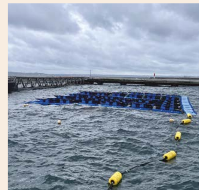
Centrale solaire flottante HelioRec dans le port de Brest.
